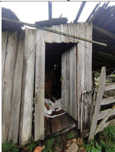
Foto 4. Abrigo Painel elétrico de acionamento do poço.
