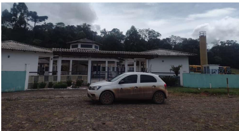
Foto 9. Colégio Municipal Barra Mansa.
