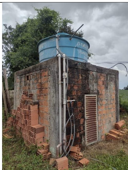
Foto 6. Estrutura de alvenaria do tratamento da água.
