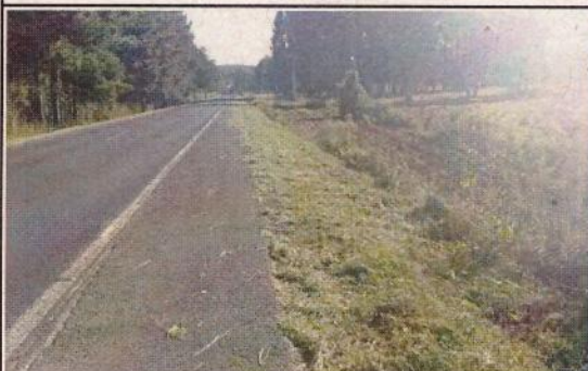
BR-280/SC - KM 245+500, Lado Direito - Serviços de Roçada e Limpeza - Foto DEPOIS
