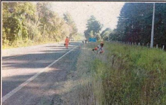
BR-280/SC - KM 246+000, Lado Direito - Serviços de Roçada e Limpeza - Foto ANTES
