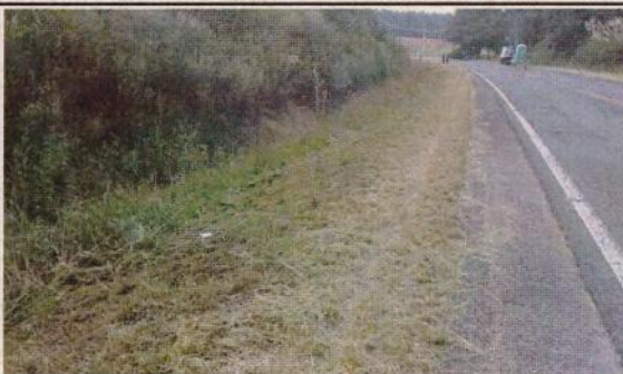
BR-280/SC - KM 239+900, Lado Esquerdo - Serviços de Roçada e Limpeza - Foto DEPOIS
