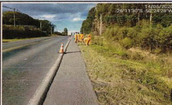
BR-280/SC - KM 234+700, Lado Esquerdo - Serviços de Capina e Limpeza - Foto DURANTE
