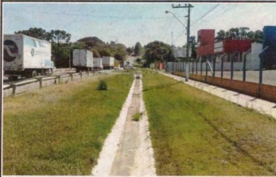
BR-280/SC - KM 232+000, Lado Direito - Serviços de Roçada e Limpeza - FOTO ANTES
